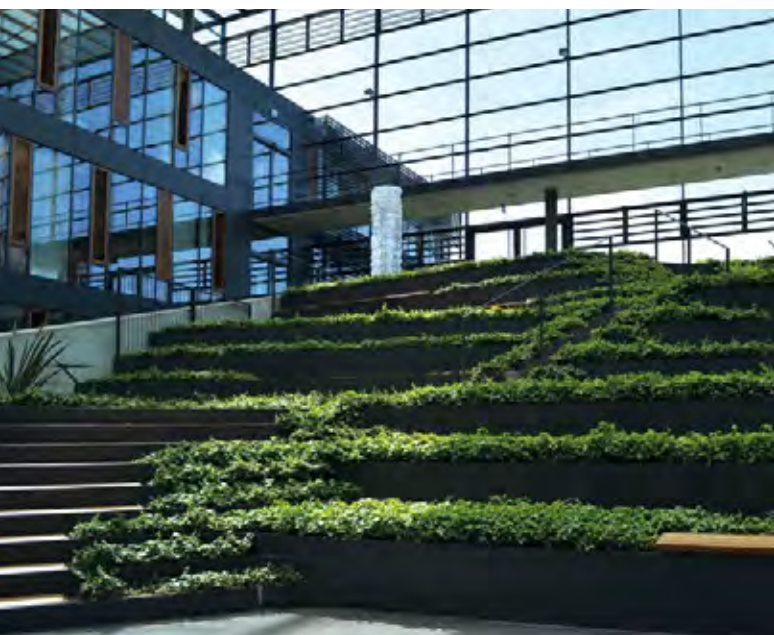
Plexiglassäule „Ringe lichter Dichte“ von Frank Maibier, Technische Universität Dresden – Neubau Biologische Institute
