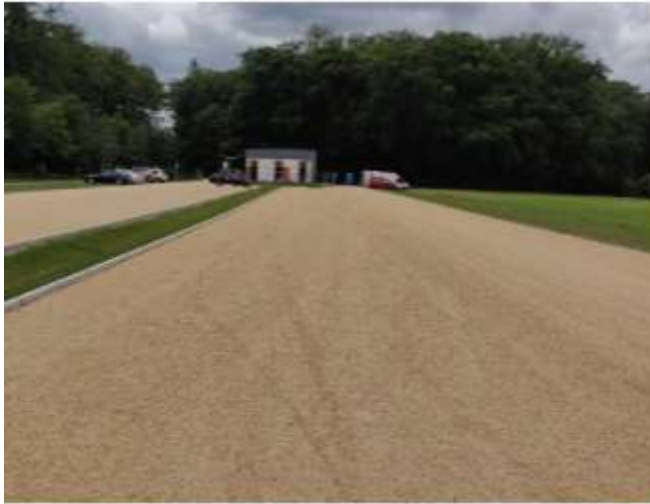
Abbildung 9: Wassergebundene Wegedecke im Farbton ocker, Abbildung: Richter+Kaup
